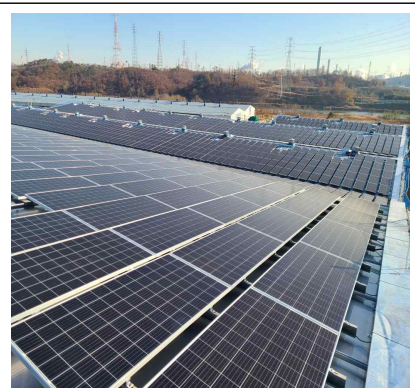
차별화된 시공 전경
