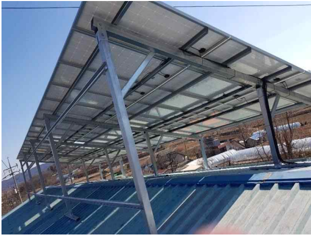
일반 지붕태양광 : 지붕 타공작업으로 누수위험 상존, 자연재해 위험 노출
