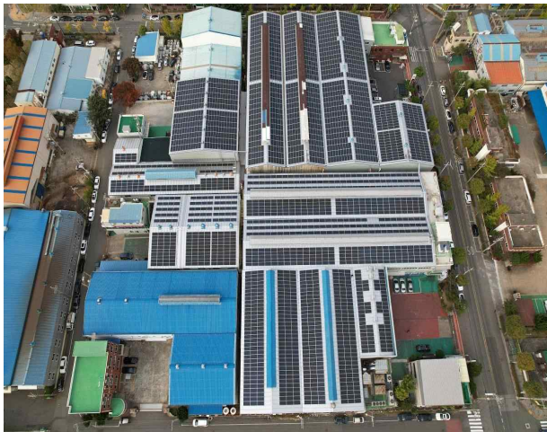
터보파워텍(부산 강서구, 1,230kW)
