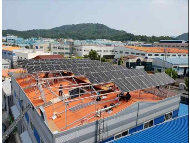
일반 지붕태양광 : 지붕 타공작업으로 누수위험 상존, 자연재해 위험 노출
